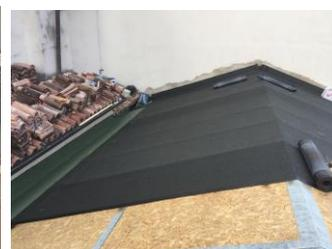
Le tegole sono state posate, come da ristrutturazione d'epoca, intersecando le nuove con quelle vecchie ben conservate per dare il senso di una costruzione invecchiata; il sottotetto è stato realizzato seguendo i disegni dell'architetto Romualdo Cambuzzi che, con gli occhi attenti di chi sa ciò che vuole e dove deve arrivare, ha controllato ogni minimo particolare per darne una composizione veramente ammirevole e degna di tanto lavoro.
